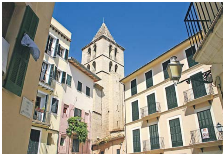
■ Das Pfarrbüro wird im Gebäude rechts von der Kirche untergebracht.
